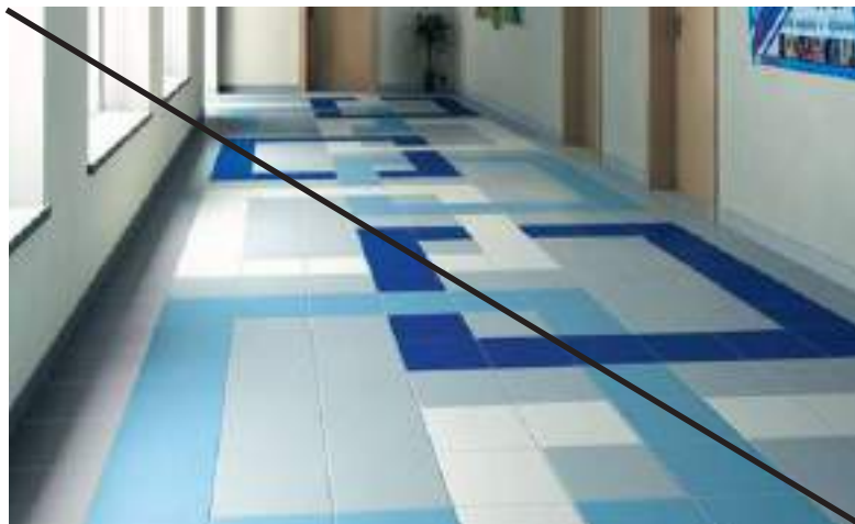
Плохо Цветные вставки из плитки
